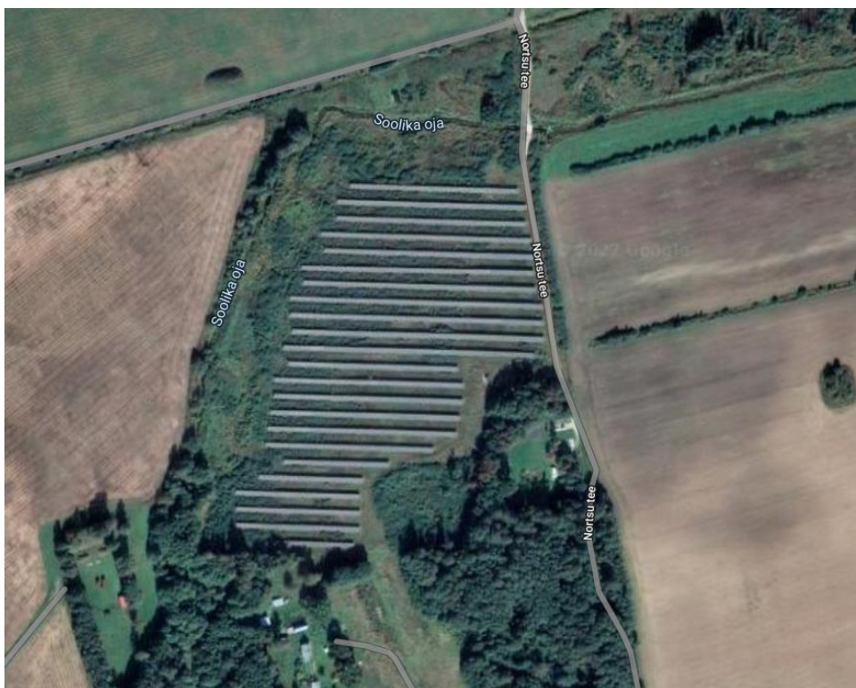
Joonis 3.4. Päikesepaneelide ilme ülelennul Lääne-Virumaal Papiniidu külas paiknevast päikeseelektrijaamast. Väljavõte: Google Maps, 2022.
