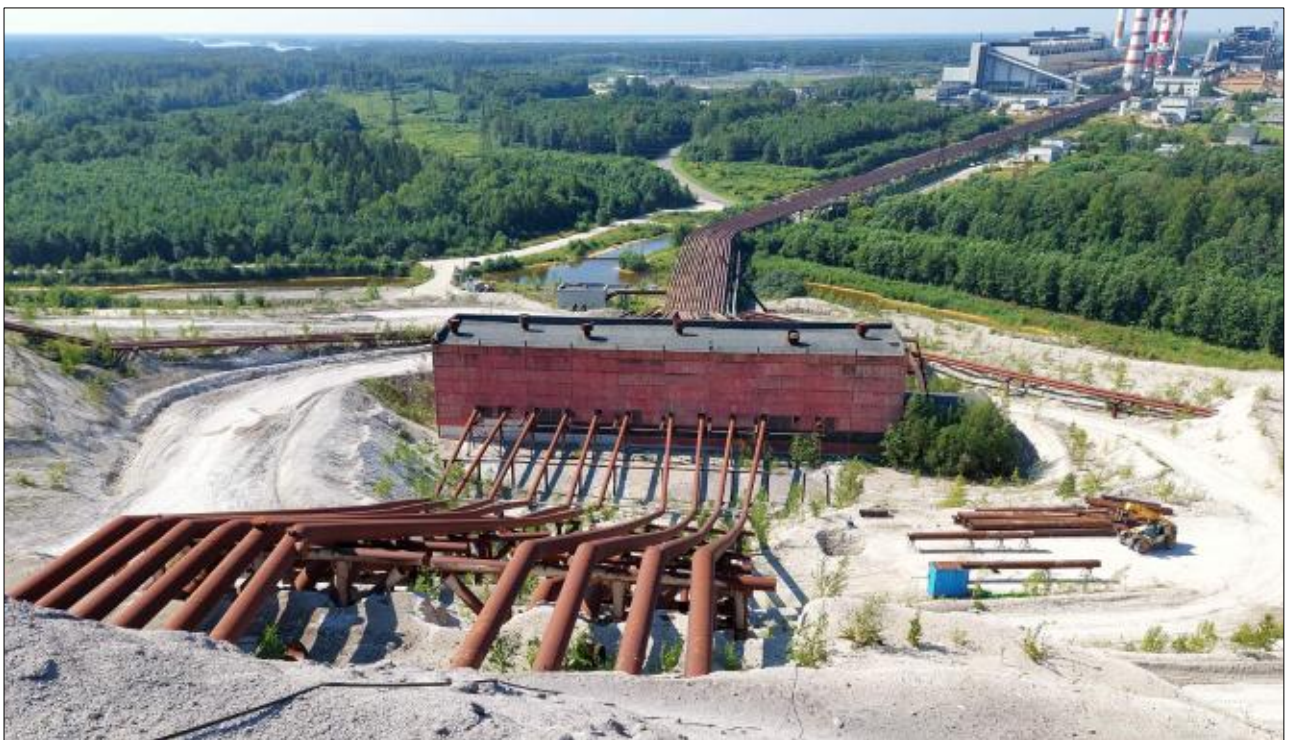
Foto 2.1 Eesti Elektrijaama tuhavälja pulbitorustik (Enefit Power OÜ)
