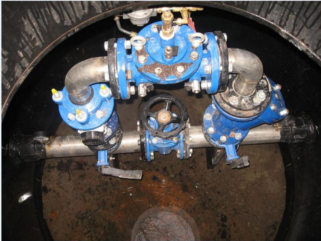
Joonis 2 regulaatorkaev
