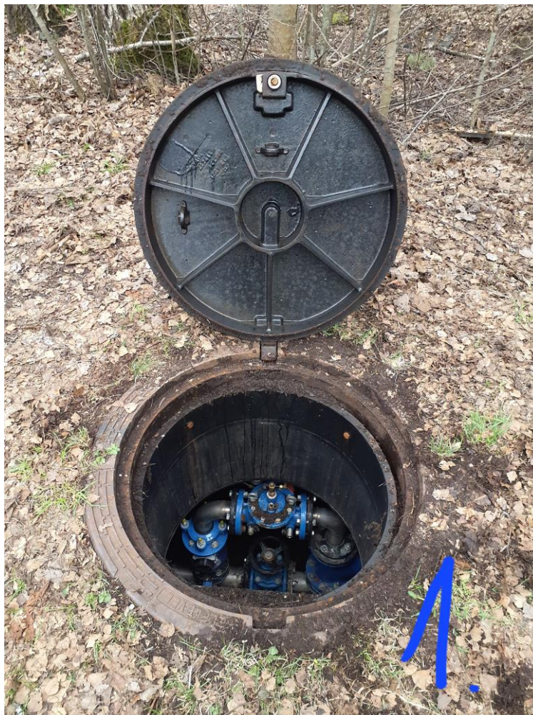
Pilt nr 1 – Olemasolev regulaatorkaev ID1500
