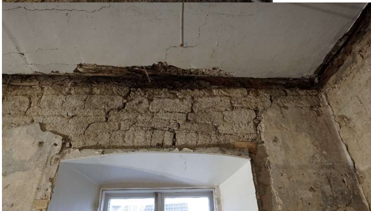
Foto 24 Eelmisel fotol kujutatud aknaava kohal olev pragunenud müüriosa
