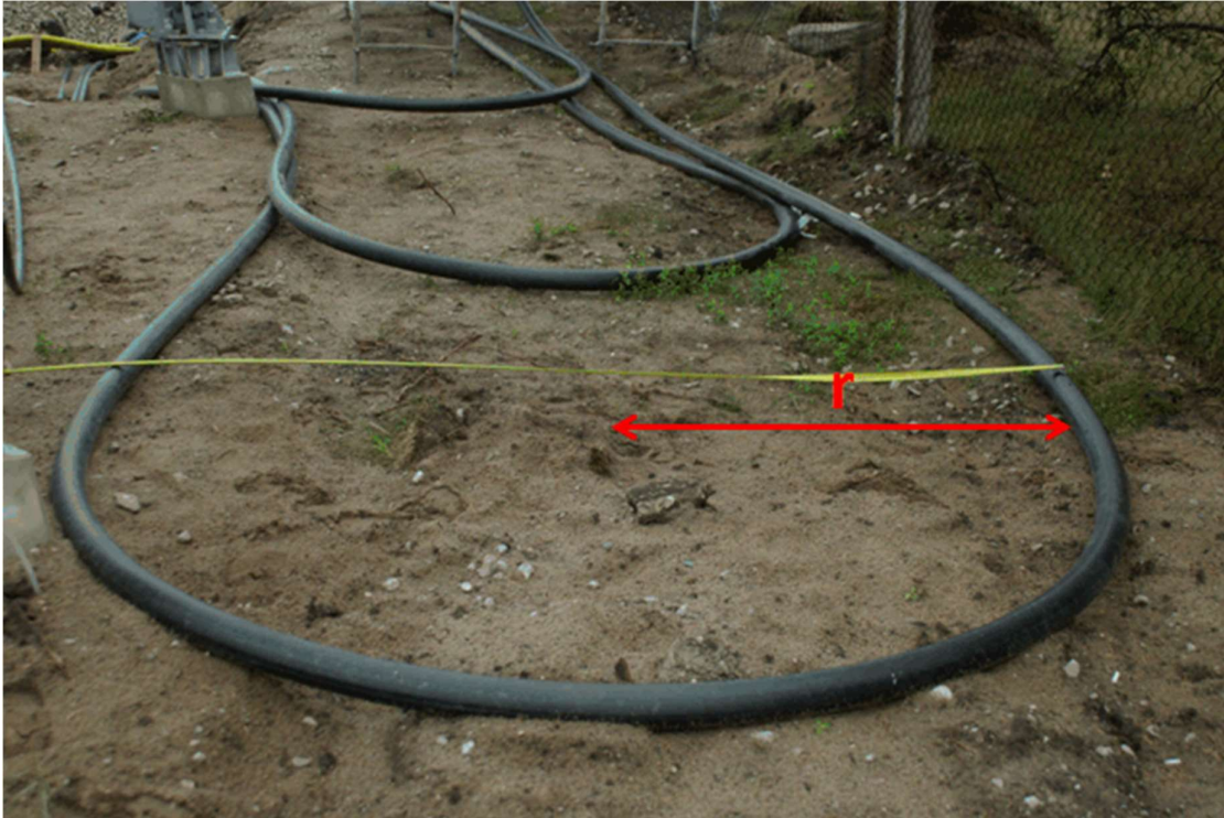
Joonis 2 Olemasoleva kaabli painderaadiuse illustatsioon
