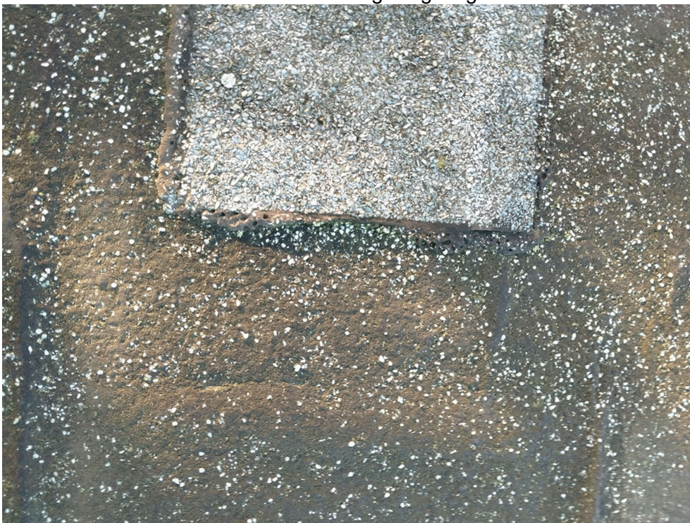
Foto 2. Hoone SBS katusekate pind ja kohtparandus. Võrdluses on näha SBS pealiskihi kattematerjali kaitsvat kiltkivikihti kohtparanduse lapil ning selle põhimõtteliselt puudumist katusekattel põhimahus.
