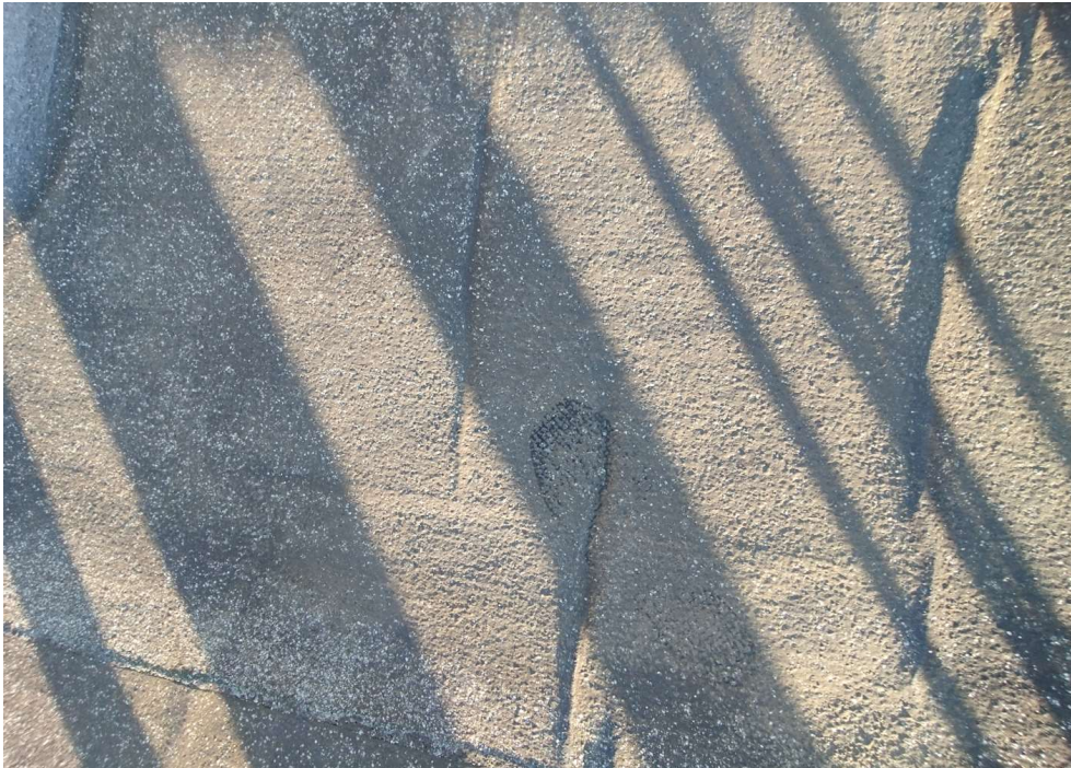
Foto 1. Hoone SBS katusekate pind. Bituumenkihti kaitsev kiltkivikiht on põhimõtteliselt täies ulatuses maha kulunud. Kortsud kattematerjali pinnal viitavad ka katte hüdroisolatsiooni kihi tugikanga lagunemisele.
