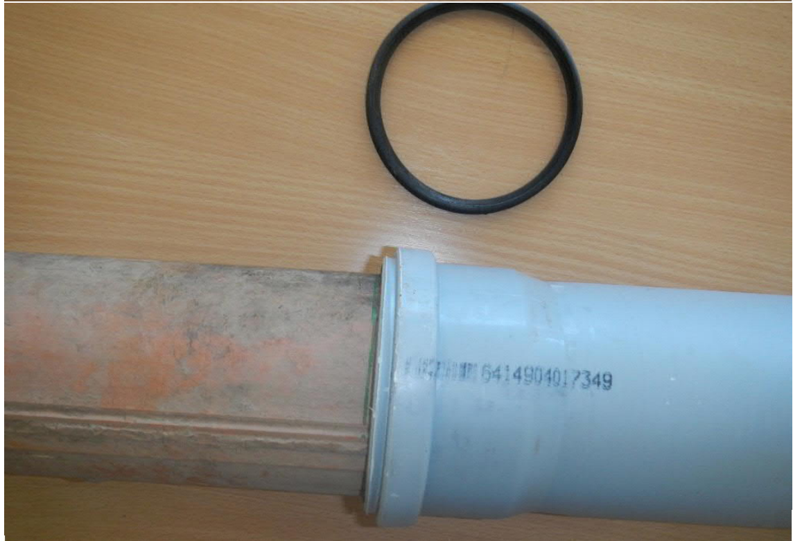
Suudmeteru M100 ühendamine savitorukollektoriga DN75 kaksikmuhviga De110
