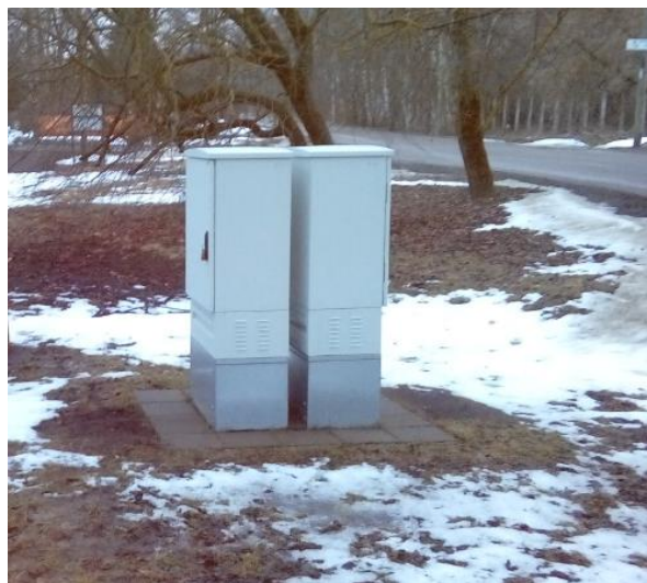
Pilt 1. Vahejaotuskapp (vasak) ja peajaotuskapp (parem)
