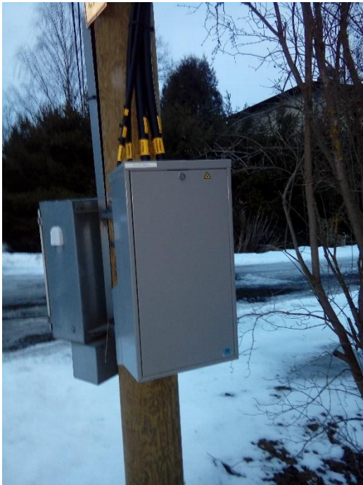
Pilt 1. Vahejaotuskapp (vasak) ja peajaotuskapp (parem)
