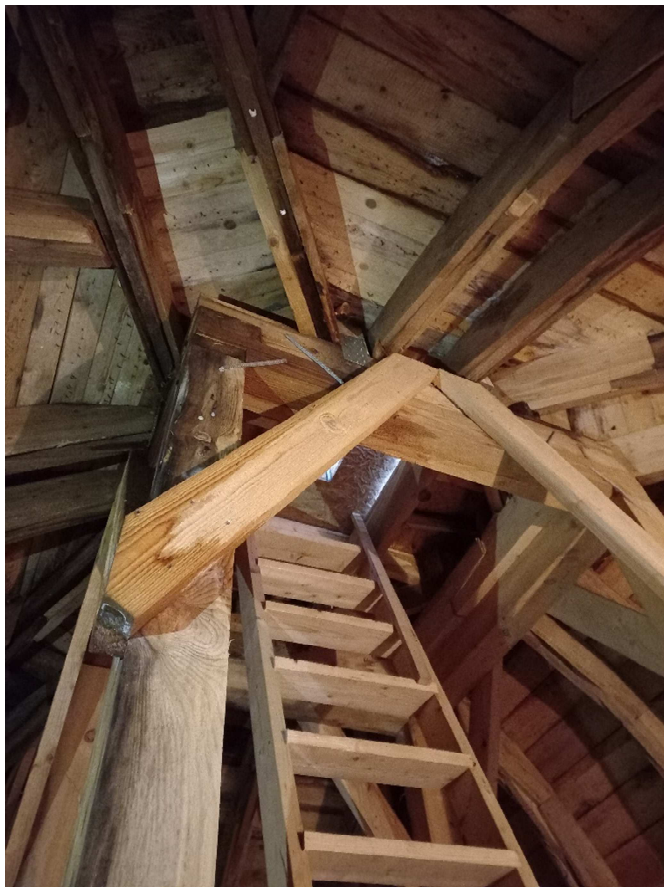
Fotod 11–13. Katusekonstruktsioon. Fotod Reelika Niit, 27.01.2023
