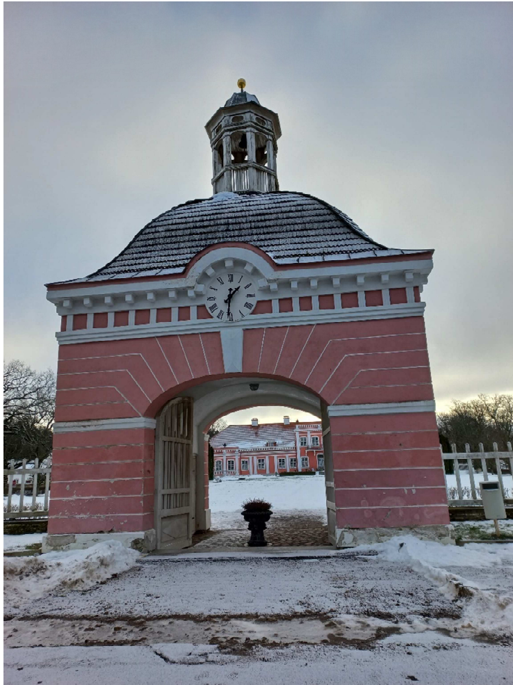
Foto 6. Väravahoone põhjapoolne fassaad. Foto Reelika Niit, 27.01.2023
