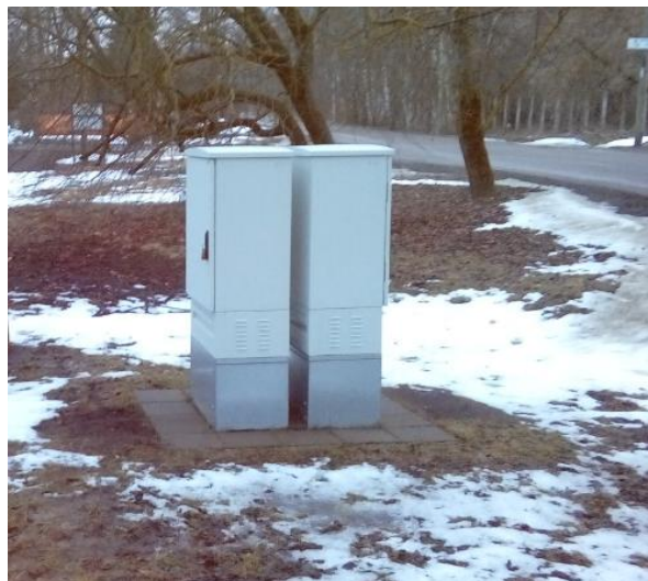
Pilt 1. Vahejaotuskapp (vasak) ja peajaotuskapp (parem)
