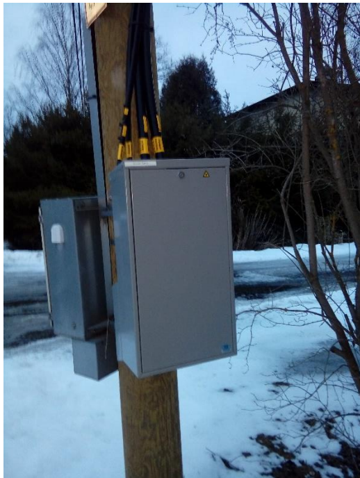
Pilt 1. Vahejaotuskapp (vasak) ja peajaotuskapp (parem)
