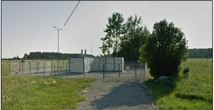
Vaade 1: 22116 Gaasijaotus-, gaasimööte- ja gaasireguleerijaam arvestusrõhuga kuni 16 bar. Asub planeeringuala sees paiknevatel tootmismaa sihtotstarbega katastriüksustel.
