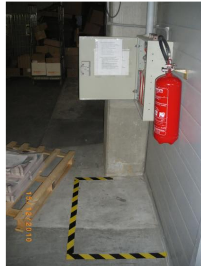
Foto nr. 2 - Tuletõrje voolikusüsteem.
