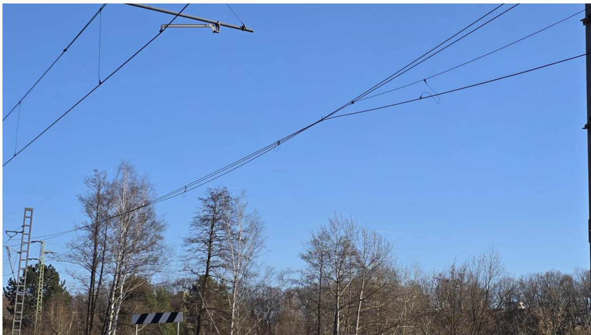
Foto 2: kontaktjuhtme tõstmine / kinnitamine tugifiidritele
