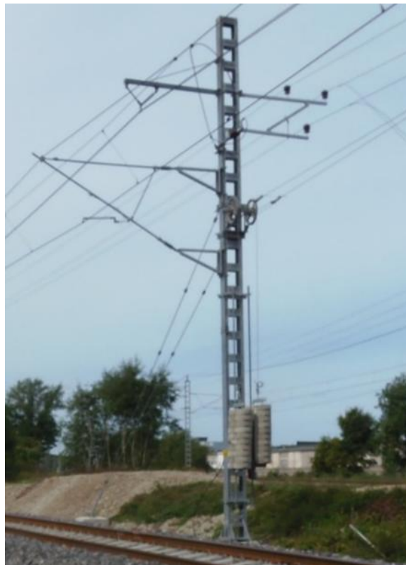
Joonis 11. Kompenseerimisseadmed
