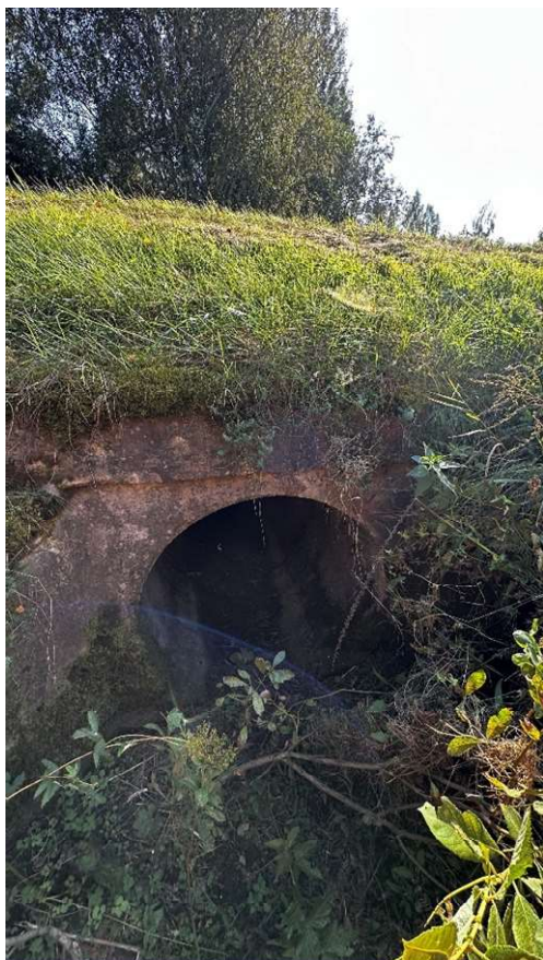
Foto 2. Riigitee all paiknev betoontorutruup DN100 cm
