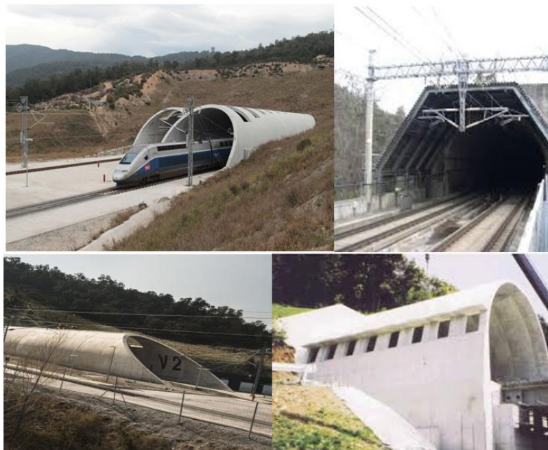
Joonis 3. Tüüp: erinevat tüüpi portaalid või konksud, mis vähendavad tunneli avausest tulenevat müra
