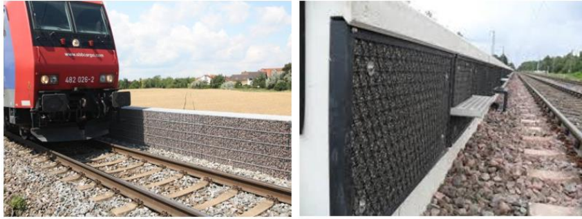
Joonis 4. Tüüp: madala kõrgusega tõke – 1 neeldumispind (kõrgus 1,0 m)
