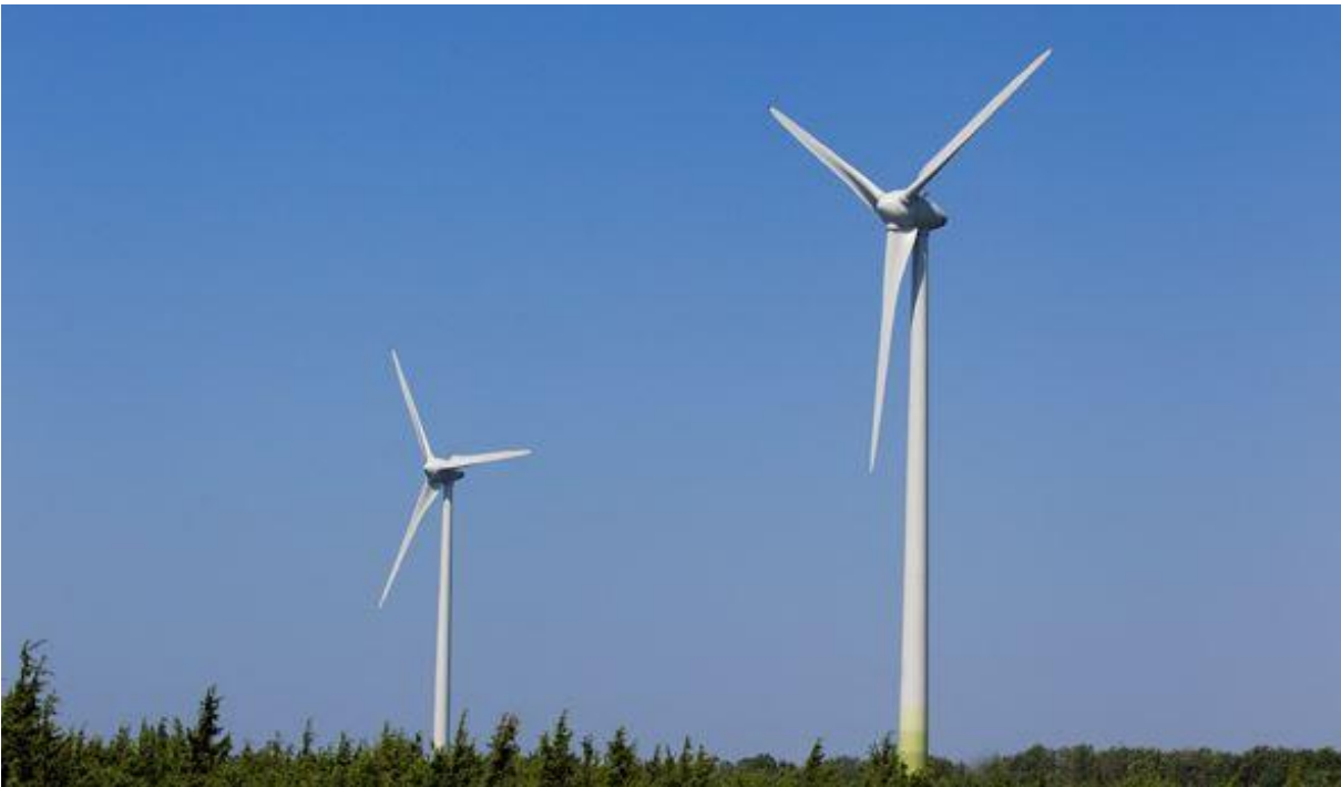
Foto 1.3.1.1 Kolmelabaline horisontaalteljega tuulik (allikas https://energiatalgud.ee/Elektrituulik#fn36 ).
