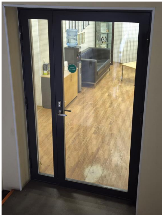
Joonis 2. Kahepoolne uks. FGDD+ A1IM E30. Ukse mõõdud 1300 x 2350 mm.
