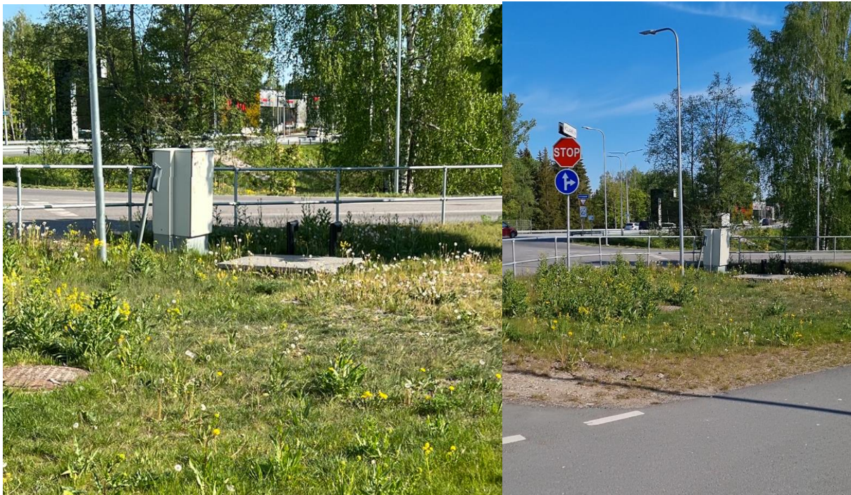
Pilt 3.4 Vanasilla tn olemasolev reoveepumpla (survetoru De160mm)
