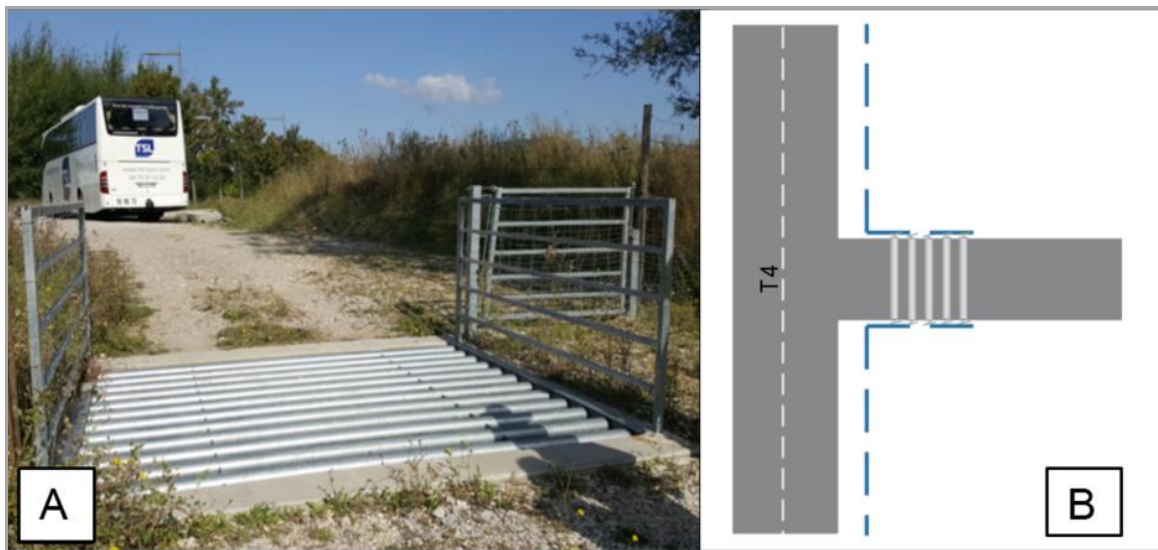
Joonis 2.10.3-2 Ulukiresti näide (A) ja skemaatiline lahendus (B, sinisega tähistatud ulukitara)
