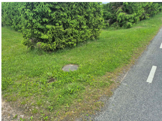
Pilt 1. Olemasolev läbipesu-kaev olemasoleva veetorustikuliini lõpus
