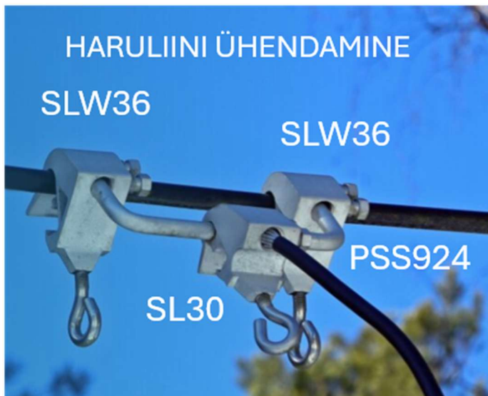
Joonis 3.1 –Haruliinide ühendamine mastidel 55, 30 ja 41.
