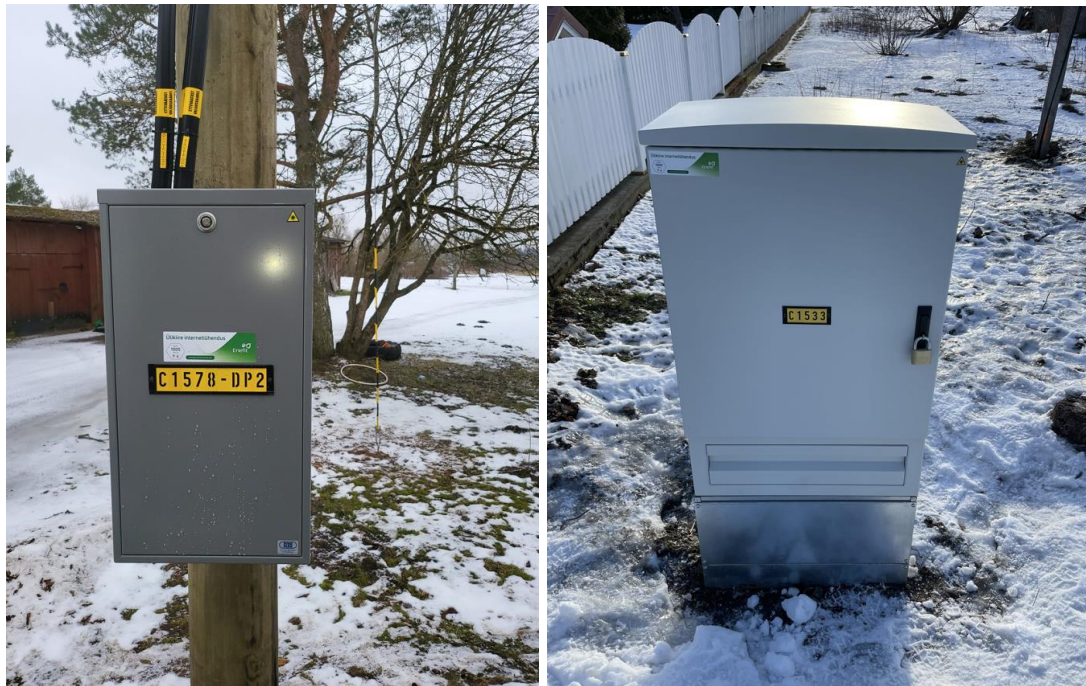
Pilt 1. Vahejaotuskapp (vasak) ja peajaotuskapp (parem)
